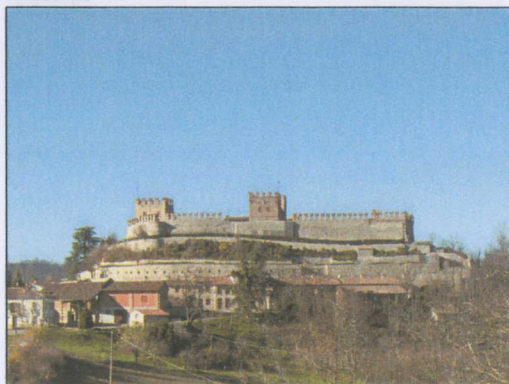
Foto panoramica dalla località Bregne
